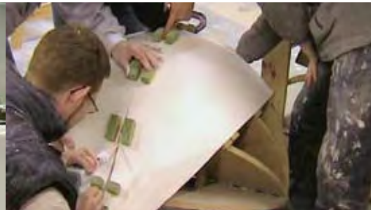
Aplicación del adhesivo DuPont™ Corian® en juntas
