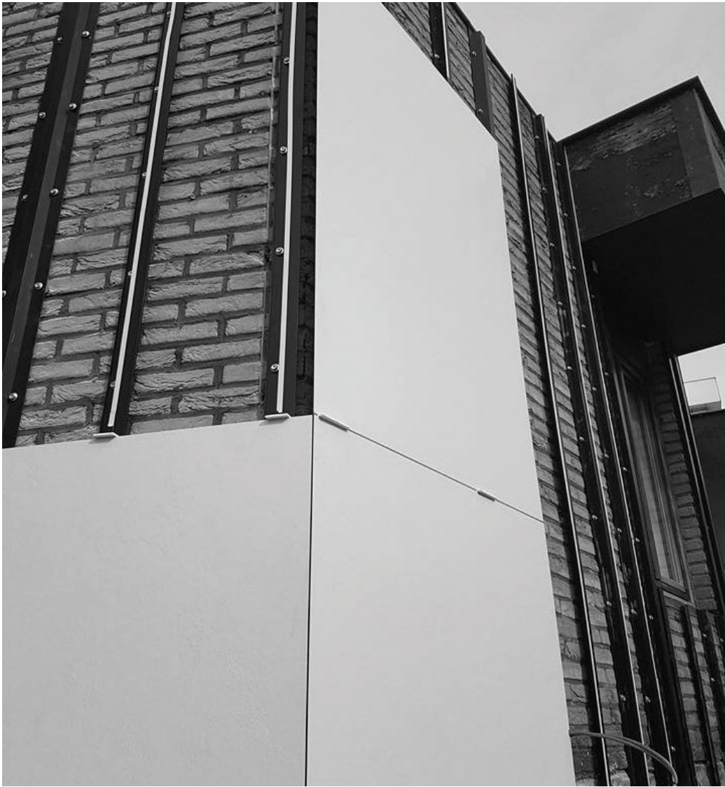
Fijación con anclaje químico sobre perfilería.
